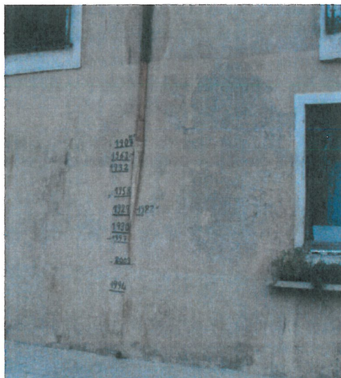
Illustration 1: Niveau des plus hautes eaux lors des différentes crues - Centre de Canet
